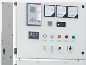
D 继电器仪表室 仪表室门关闭，仪表室正视图。
